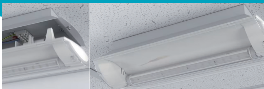
Horizon- en Aqualux-noodverlichtingstoestellen vs versie uitgerust met LED-renovatiemodules
