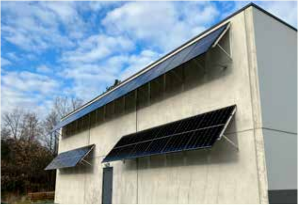
Gevelmontage van zonnepanelen in Verviers
