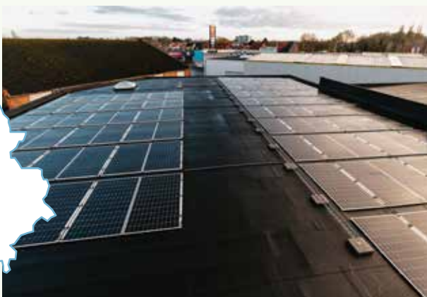
Lichte flexibele zonnepanelen op het dak van Kuurne
