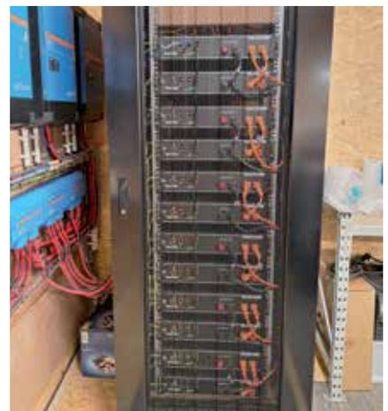
Dans le système de Xavier Verfaillie, les onduleurs des panneaux solaires sont connectés à 12 batteries au lithium (type LFP) qui délivrent une puissance totale de 28,8 kWh. « C'est l'équivalent de la consommation énergétique quotidienne d'environ 2,5 ménages », indique Jeroen à titre de comparaison. Ces batteries sont à leur tour connectées aux onduleurs Multiplus II de Victron Energy qui convertissent le courant continu en courant alternatif.
