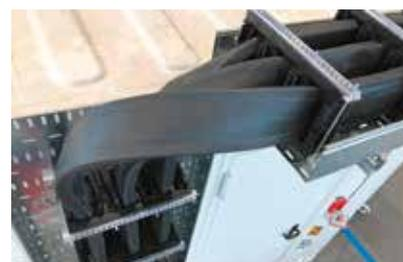
En effet, l'offre permet une réduction de la section des conducteurs par la géométrie rectangulaire. Moins d'effet de peau, donc moins de matière à utiliser pour véhiculer le courant. Cela engendre également une réduction de l'utilisation de cuivre ; le conducteur est en effet fabriqué avec 90% d'aluminium et 10 % de cuivre. Sans compter que les emballages utilisés sont recyclables, fabriqués en France et à partir de cartons recyclés.
