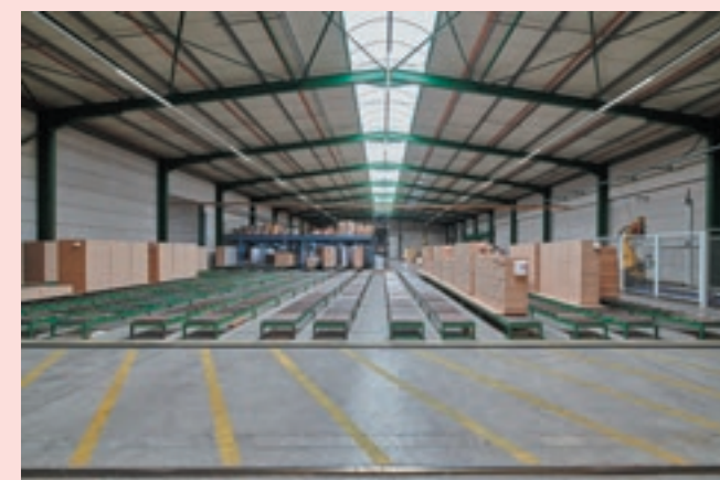
Na de renovatie, met de nieuwe TRILUX-lichtlijnsystemen
