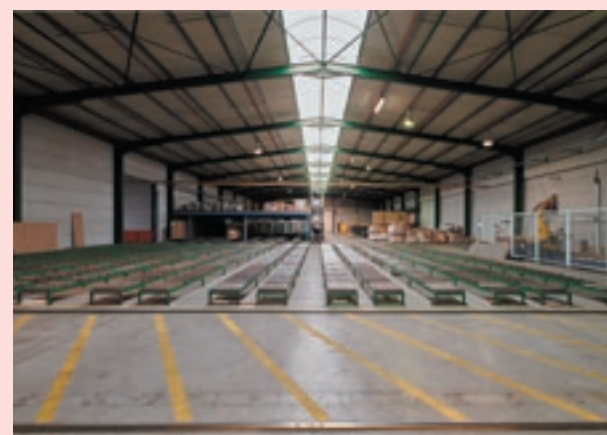
Een Bauwens-productiehal voordat het renovatieproject is gestart
