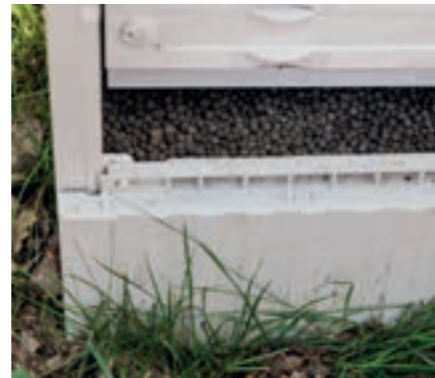
Granulaatkorrels voorkomen vocht in het verdeelbord.
