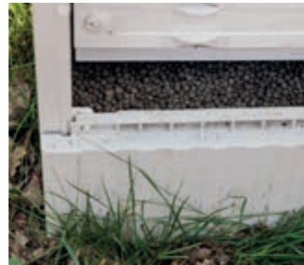
Les granulés empêchent l'humidité de s'accumuler dans le tableau de distribution.
